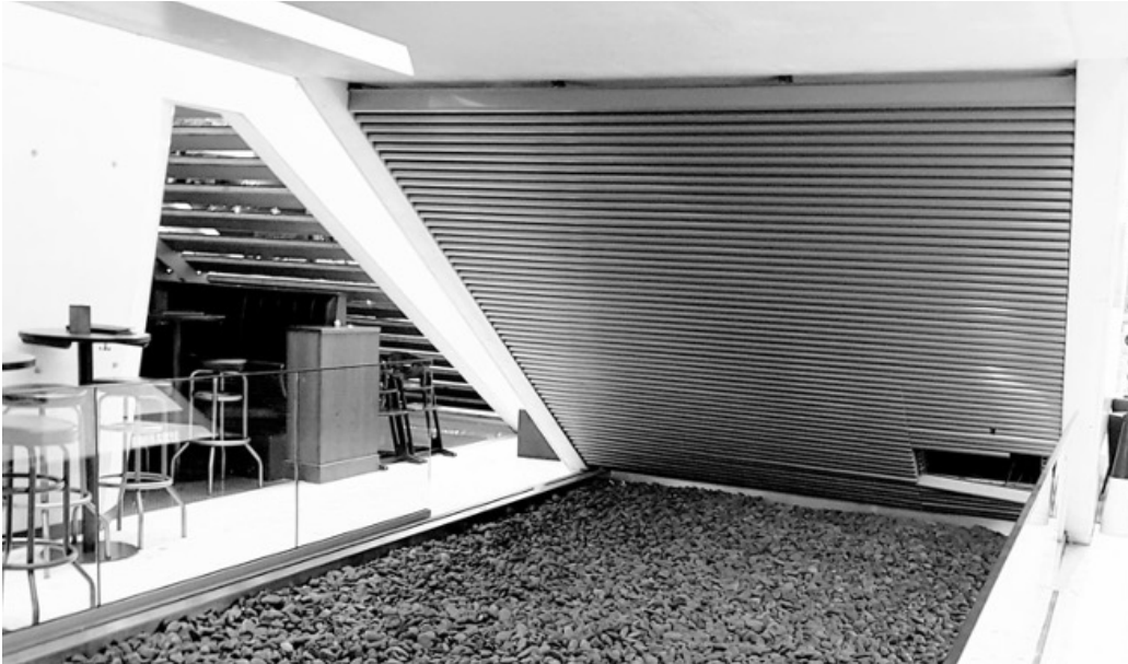
Kan användas som avskärmning från tekniska installationer, som i detta fallet maskineriet i en rulltrappa.
